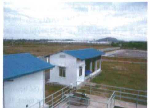
水処理場(下の地図赤色部分)から眺めた現場風景
