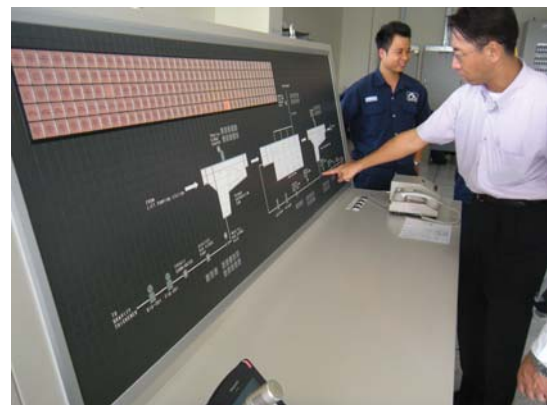
異常を監視するモニタリングルーム
