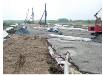
高架橋の施工状況
