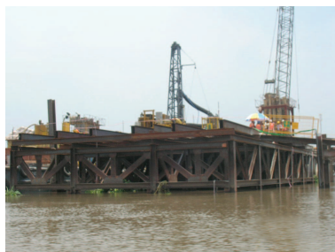
ロンタイン橋基礎工施工状況
