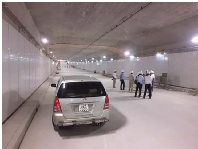
トンネル内部
