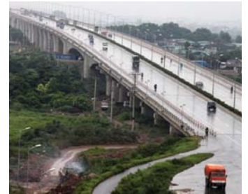
紅河橋(タインチ橋)建設事業
