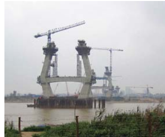
ニャットタン橋(日越友好橋)建設事業
