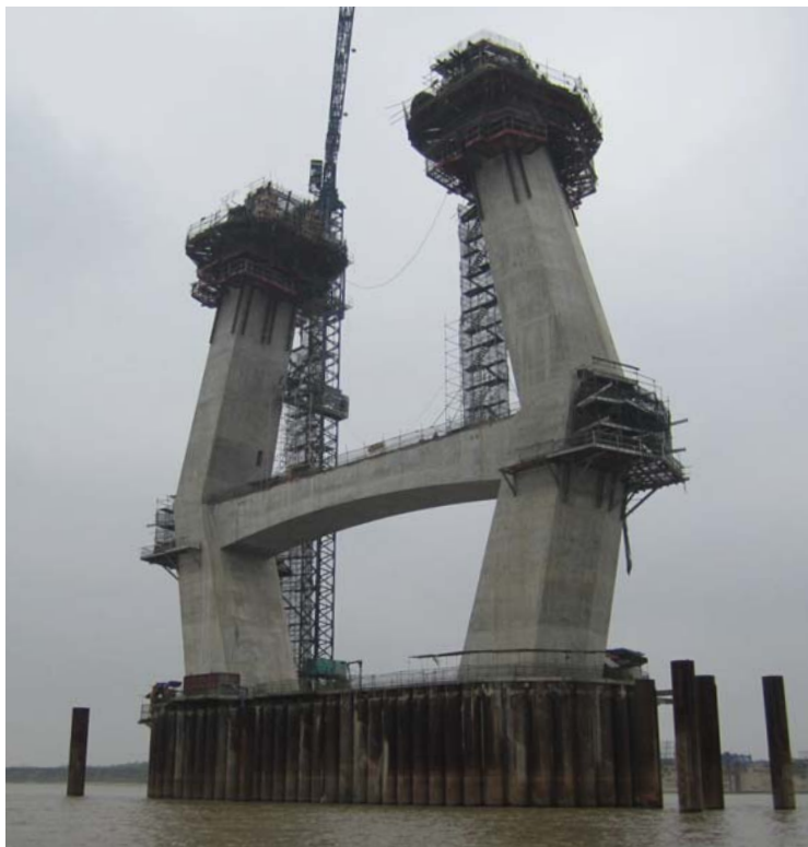
主橋梁河川内主塔工事(上部仮設鋼管は工事終了後撤去)
