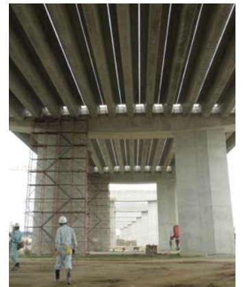
北側取付橋梁部工事
