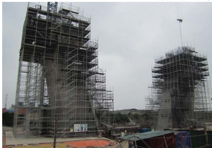
主橋梁陸上部主塔工事
