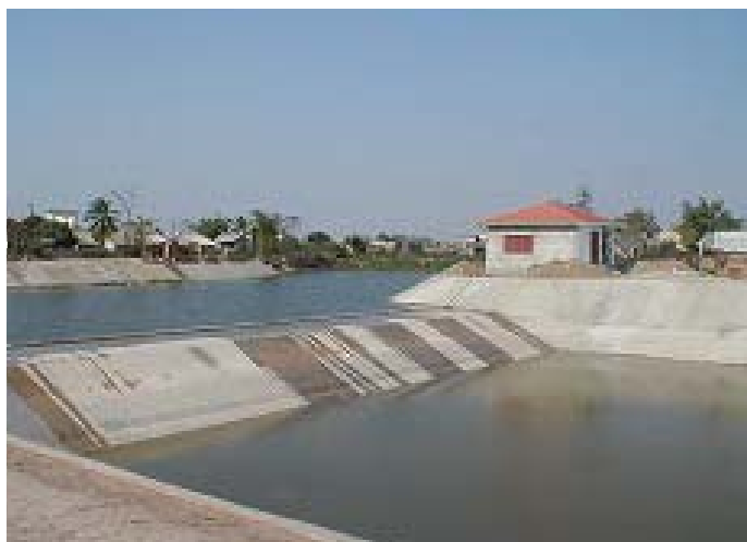
イエンソーポンプ場の余水吐け
