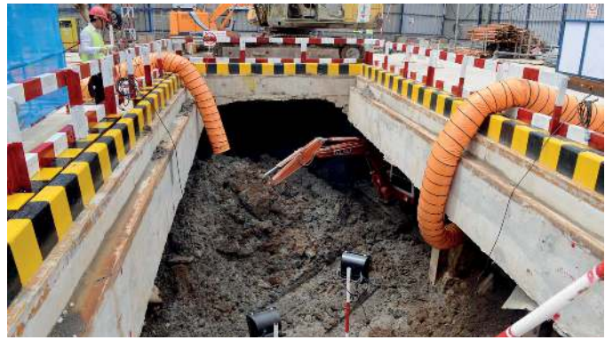
オペラハウス駅掘削工事
