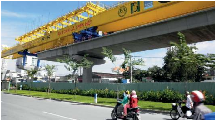
プレキャストセグメント工法による高架橋建設現場 (提供:住友商事)
