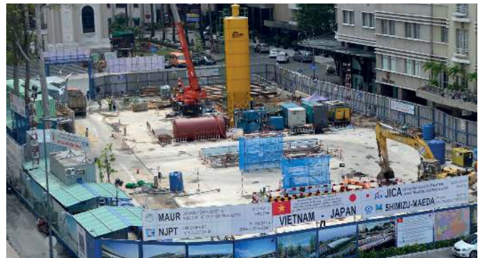
オペラハウス前の工事現場
