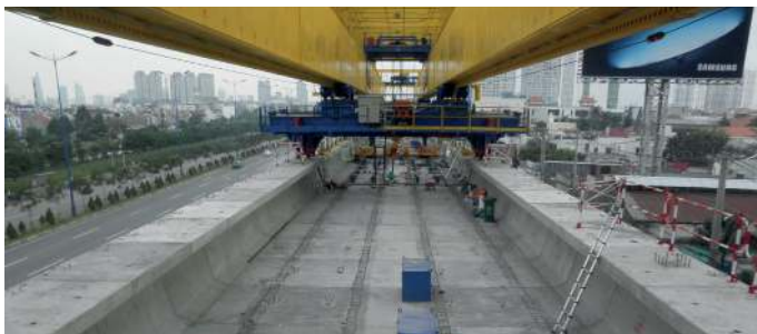
プレキャストセグメント工法による高架橋建設現場 (提供:住友商事)
