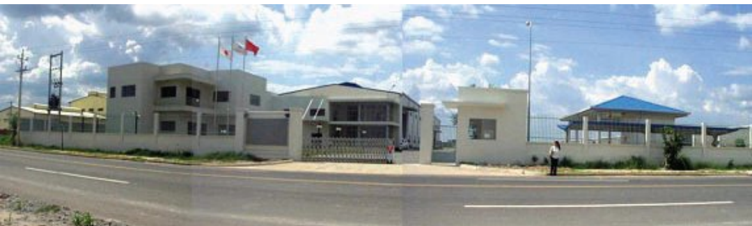
ベトナム工場 ビンズン省パウバン工業団地
