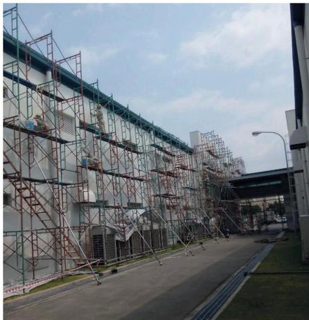
質は、お世辞にも良いとは言えないものばかりです。ローカル企業の施工した塗装は、雨季になると問題が発生して、再塗装となるものが多くあります。これは、塗料などの問題もないわけではありませんが、最も根本的な問題として、下処理が十分にされていないことが、最も大きな原因です。私自身、塗装は下処理がすべてだと感じていますし、この下処理が十分にできていない場合、幾らきれいに塗装を行っても直に劣化が起きてしまいます。下処理段階で、最も重要なことは、水の浸入を防ぐことです。塗装の劣化が起きる原因は、コンクリートに水がしみ込むで起きるのが殆どです。これを防ぐためには、まず、コンクリートへの水の浸入を防ぐことから始めなければなりません。
