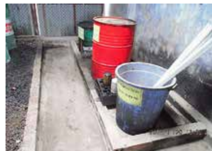
▲危険物置き場の漏洩防止対策
