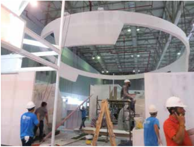
▲設置中の大型ブース
