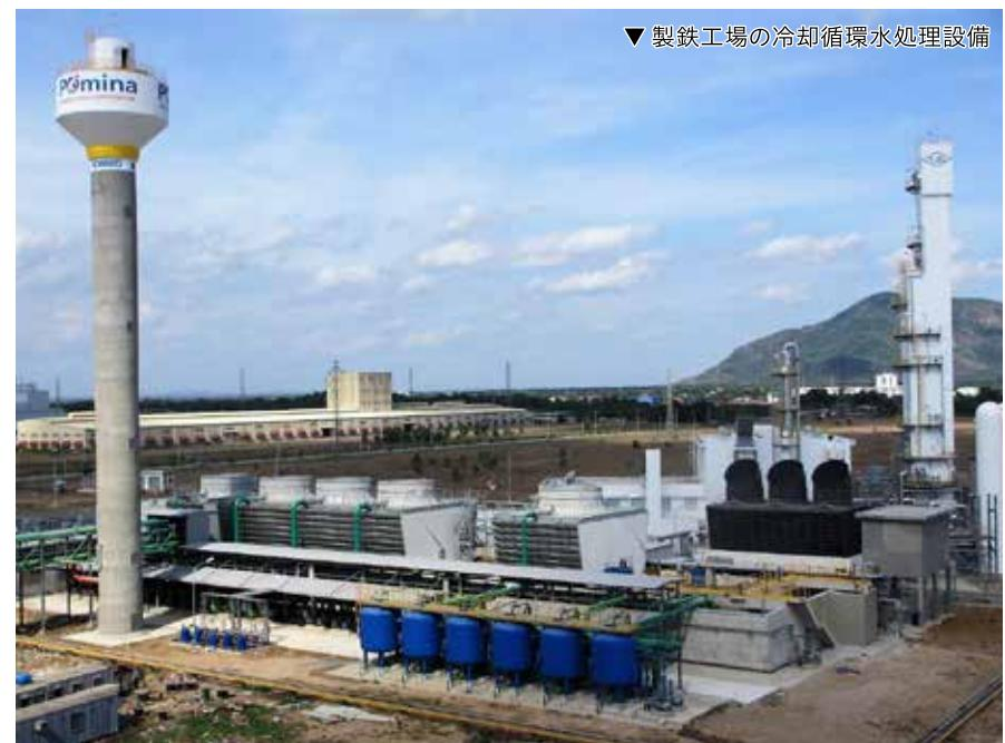
▼製鉄工場の冷却循環水処理設備
