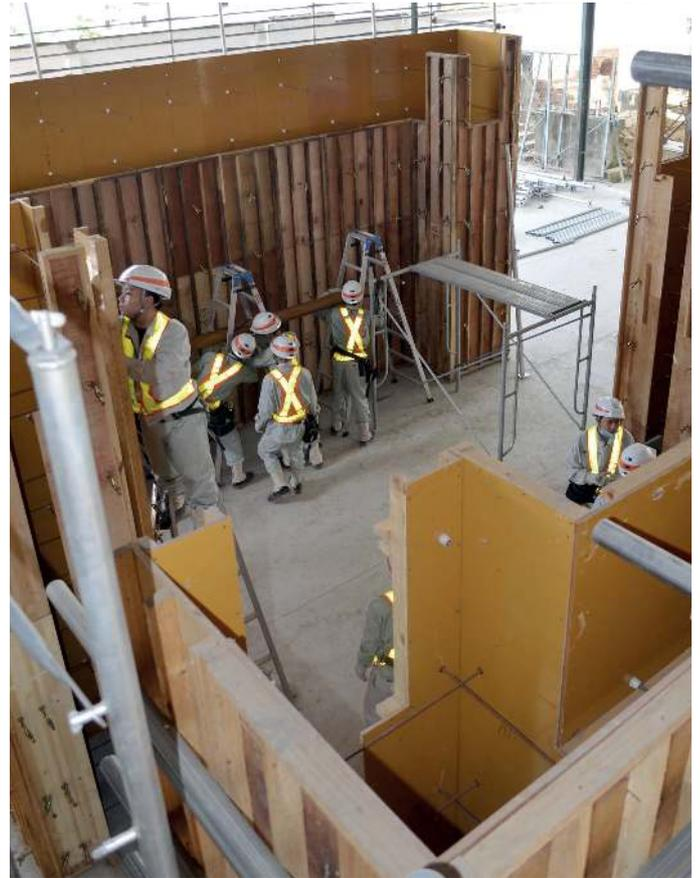
います。朝はラジオ体操・ミーティングから始まりKY活動後、3-4名のグループに別れ各自で指示を受けた作業をします。墨出し、建込み、足場組み立て、セパレーター打ち込み、型枠解体までを一連の流れとして日本の実際の現場を想定して作業を実施します。
