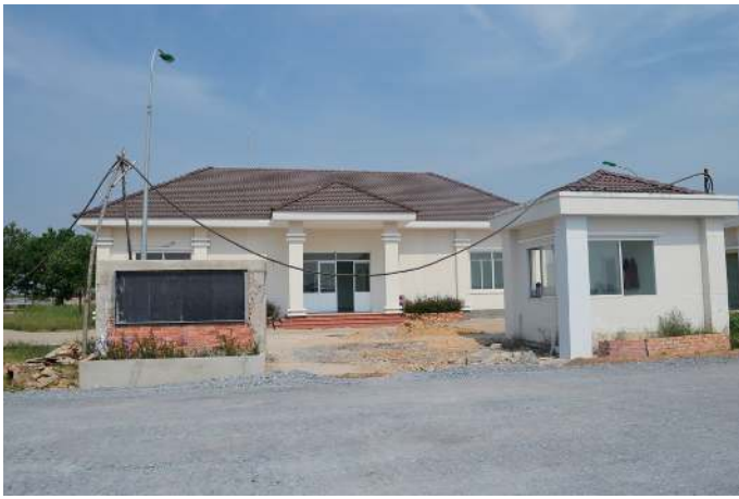
排水処理施設
