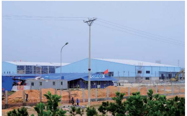
建設中の工場
