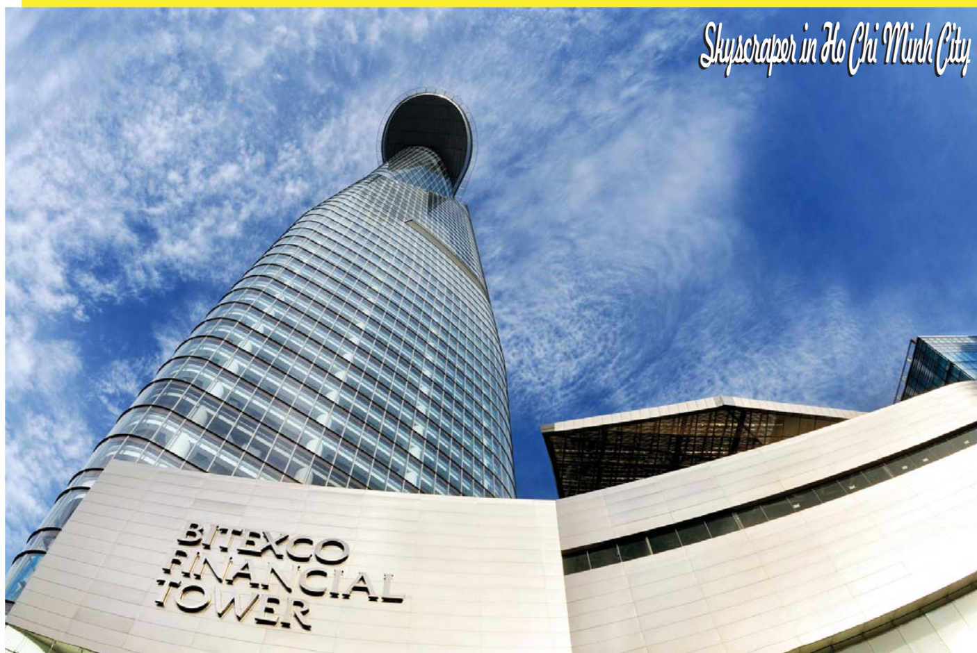
地上から見上げるビテクスコ・フィナンシャルタワー(写真:Bitexco Company提供)
