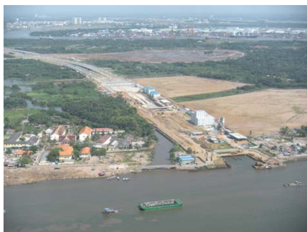
2区側の東西大路の展望(川の下がTU THIEMトンネル)
