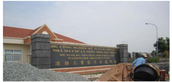
排水処理施設
