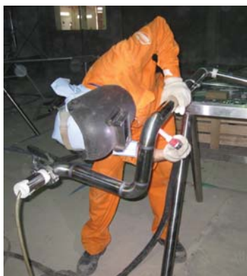
溶接作業風景
