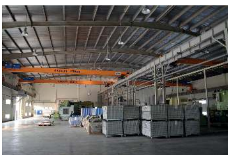
大型クレーン設備
